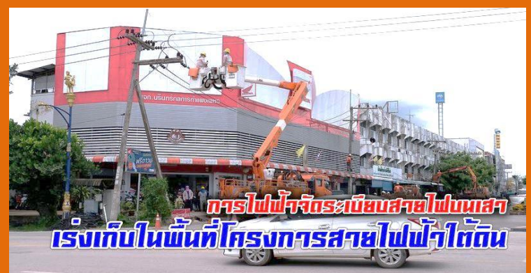
Target 11.3 โครงการเปลี่ยนระบบสายไฟฟ้าอากาศ เป็นสายไฟฟ้าใต้ดิน
